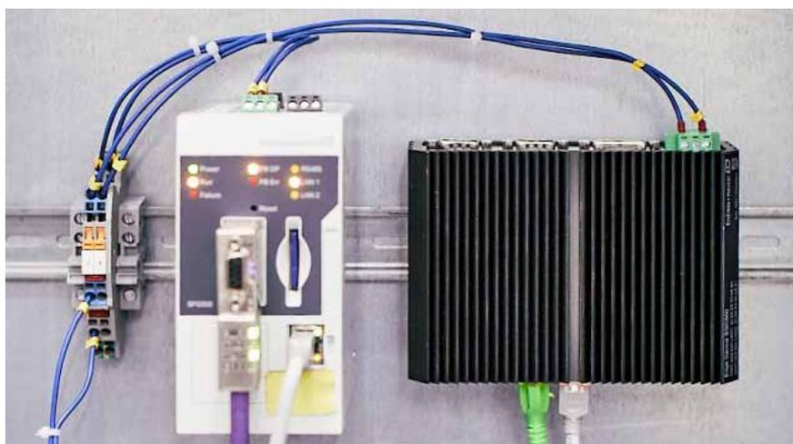
**Réalisation** Des employés de Salzgitter Flachstahl GmbH ont installé la passerelle Ethernet/PROFIBUS SFG500 ainsi qu'un Edge Device directement connecté à Internet dans le réseau PROFIBUS. La passerelle et l'Edge Device assurent tous deux la connectivité entre l'informatique (IT) et les techniques d'exploitation (OT), et scrutent automatiquement l'ensemble de l'installation à la recherche d'appareils de mesure, qu'ils soient d'Endress+Hauser ou d'autres fabricants.
